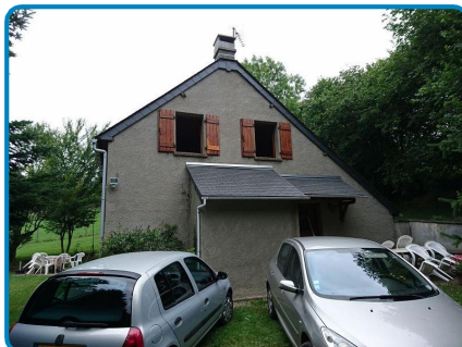
Maison principale Rez de chaussée Extérieur
