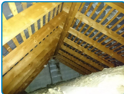
Maison principale 2ème étage Combles
