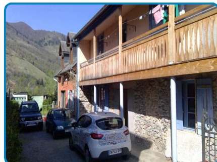
Maison principale Rez de chaussée Extérieur
