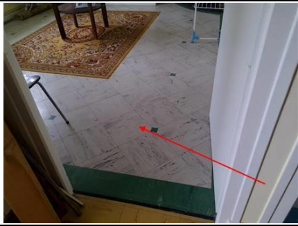
Photo n° A008 Localisation : 1er étage - Salon 2 Ouvrage : Planchers Partie d'ouvrage : Dalles de sol Description : Dalles de sol Localisation sur croquis : 008
