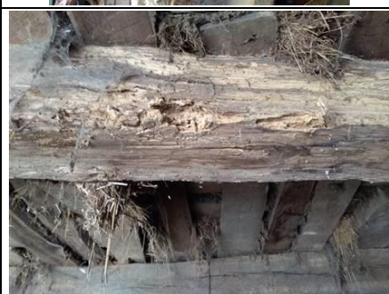
Photo n° PhTer002 Localisation : grange partie ouest Ouvrage : Poutres (Bois)
