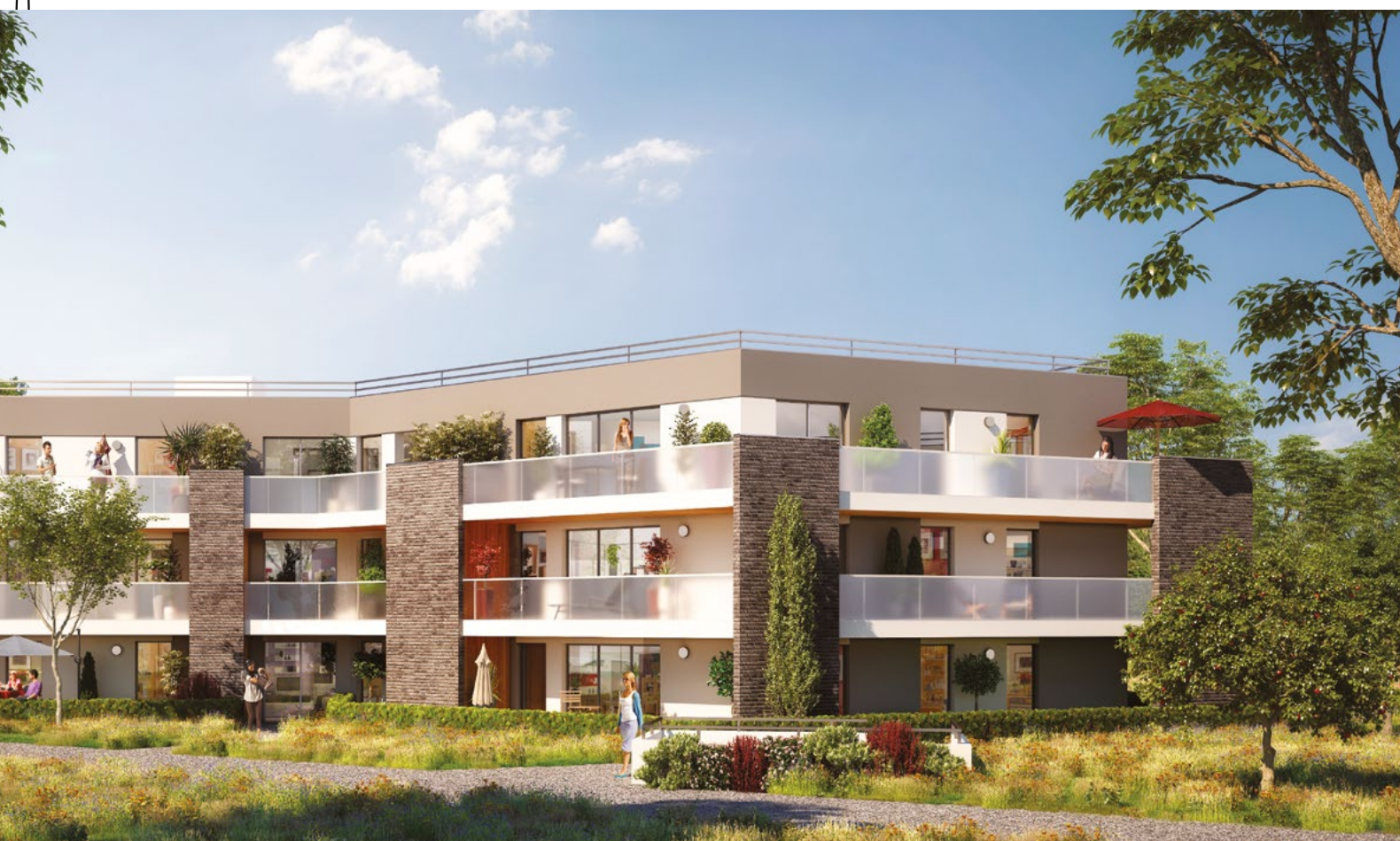
Vue du bâtiment A.
