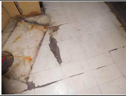
Photo n° A003 Localisation : Rez de chaussée - Bar Ouvrage : 5. Planchers et planchers techniques - Revêtements de sol Partie d'ouvrage : Dalles plastiques Description : Dalles plastiques Localisation sur croquis : 003
