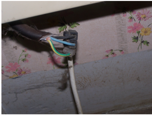
Conducteurs apparents non protégés convecteurs
