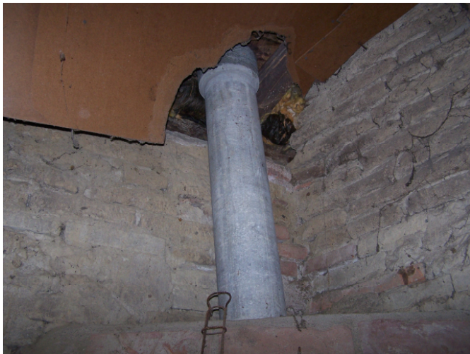
Conduit de fumée amiante ciment ancien chai
