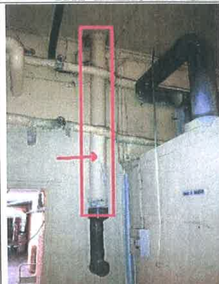
Photo n° PHOTO001 Localisation : Laverie Ouvrage : Conduits, canalisations et accessoires intérieurs et extérieurs - Conduits de fluides (air, eau, vapeur, fumée, autres fluides) Partie d'ouvrage : Conduit Description : Conduit Localisation sur croquis : Point 001
