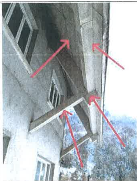
Photo n° PHOTO004 Localisation : Extérieur - Façades Ouvrage : Parois verticales extérieures - Bardages Partie d'ouvrage : Plaques Description : Plaques habillages des volets de toiture et Ossature de charpente et lucarne Localisation sur croquis : Point 004
