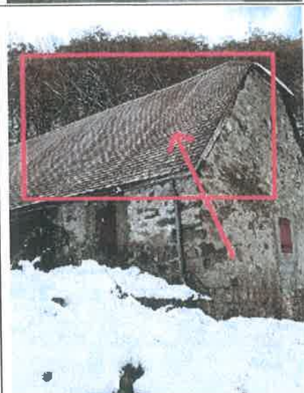
Photo n° PHOTO005 Localisation : Grange - Toiture Ouvrage : Toiture, terrasse et étanchéité - Ardoises Partie d'ouvrage : Ardoises en fibres-ciment Description : Ardoises en fibres-ciment Localisation sur croquis : Point 005
