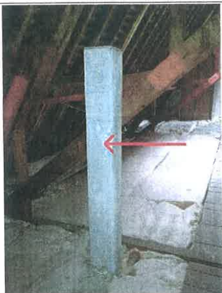
Photo n° PHOTO003 Localisation : Combles - Combles Ouvrage : Conduits, canalisations et accessoires intérieurs et extérieurs - Conduits de fluides (air, eau, vapeur, fumée, autres fluides) Partie d'ouvrage : Conduit Description : Conduit Localisation sur croquis : Point 003
