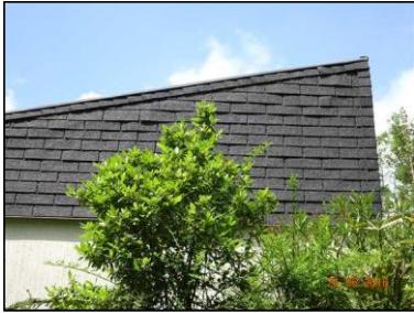
Toiture en single
