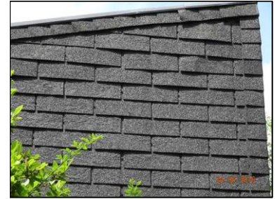
Toiture en single
