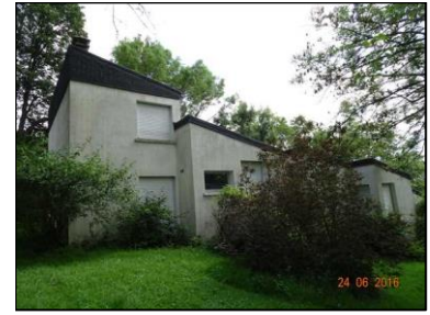
Toiture en single
