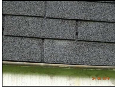
Toiture en single
