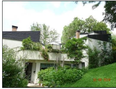
Toiture en single
