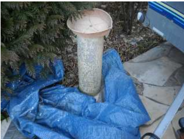
028 - Maison - Jardin PH3 : Tuyau servant de coffrage perdu
