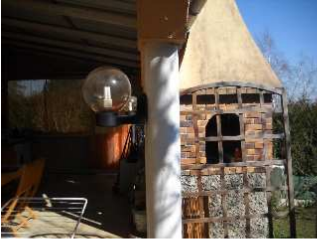
026 - Maison - Véranda PH1 : Tuyau servant de coffrage perdu
