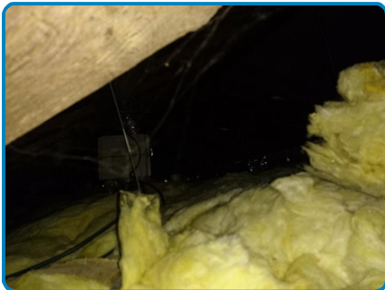
Maison principale 2ème étage Combles
