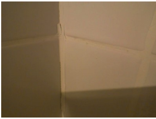
Salle de Bains /WC : Faïence : Joint Ciment
