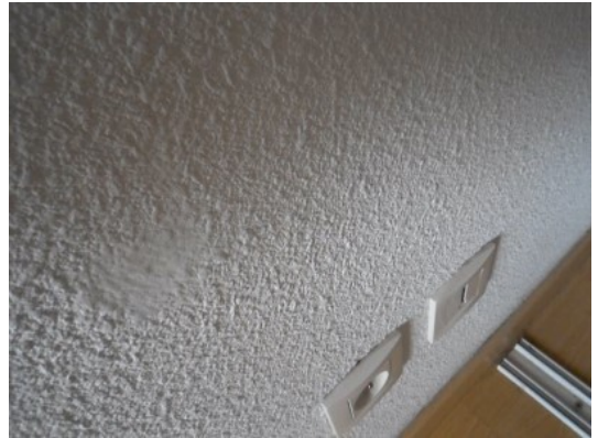
Chambre : Mur face Gouttelette
