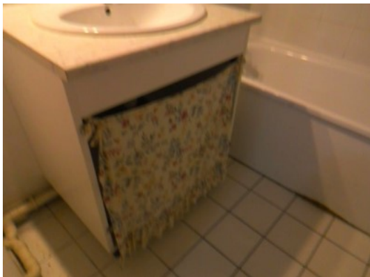
Salle de Bains /WC : Meuble sous lavabo Panneau de particules surfacé mélaminé
