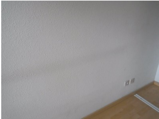
Chambre : Mur face Gouttelette
