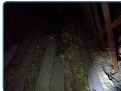
Maison principale 1er étage Combles
