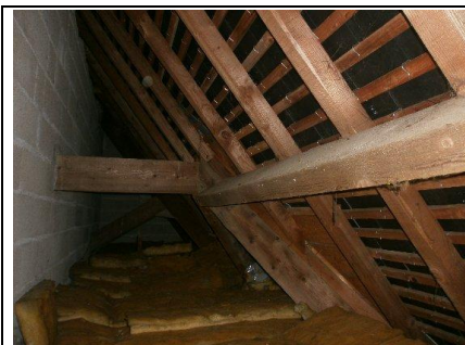
Photo n°002 Localisation : Comble Ouvrage : Charpente (poutres, pannes , chevrons,...) Description : Résultat de l'inspection : Absence d'indice d'infestation de termites (Informations complémentaires : Présence d'injecteurs sur la charpente)
