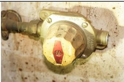
Réserve : présence d'une vanne RCA gaz et absence de bouchon en sortie de vanne (Installer un bouchon).
