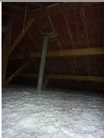
Photo n° 1038A2 Localisation : Comble perdu Ouvrage : CANALISATION FIBROCIMENT AMIANTE M002
