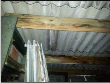
plaque ondulée en fibre ciment en toiture du garage 2
