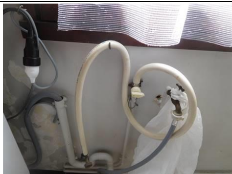
Photo n° Gaz002 Localisation : Rez de chaussée - Buanderie Cuisinière Robinet en attente (Type : Non raccordé)
