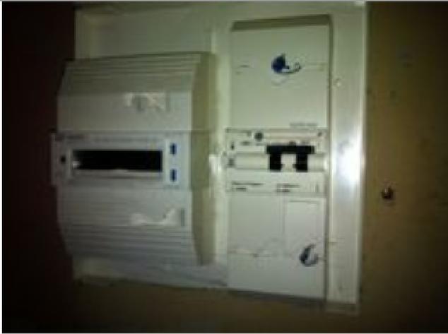
Entrée: Disjoncteur général avec une protection différentielle de 500 mA et un courant assigné de 30 A monophasé:
