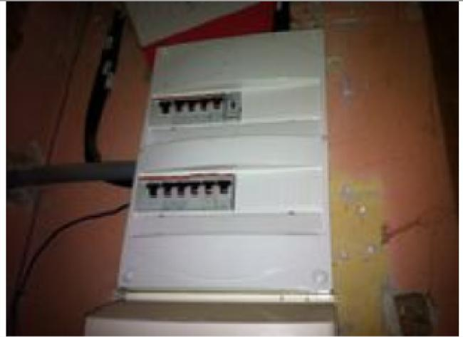
Entrée: tableau de répartition avec disjoncteur magnétothermique:
