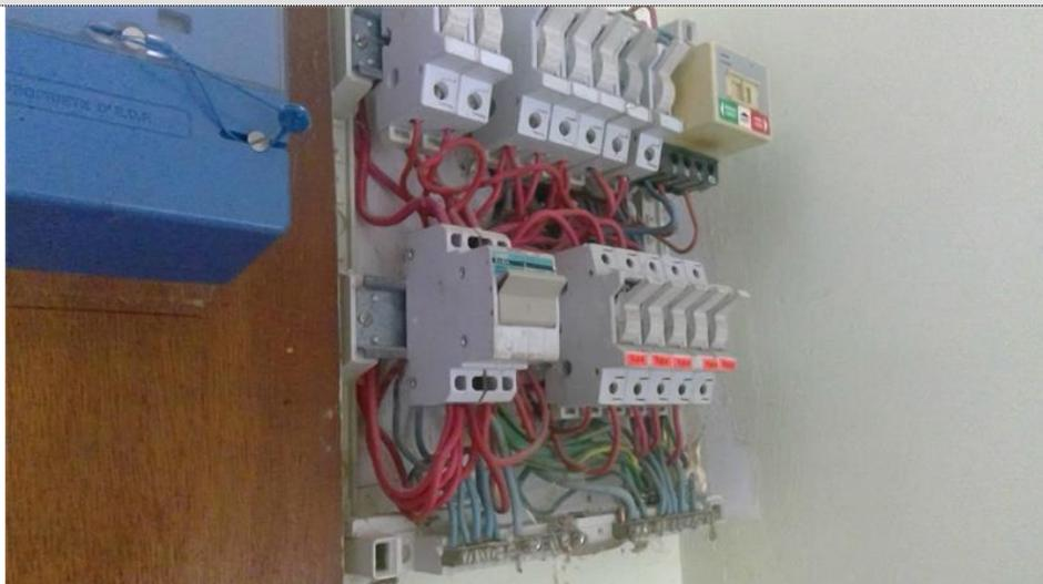
Description : Au moins un dispositif de PROTECTION CONTRE LES SURINTENSITES n'est pas placé sur un CONDUCTEUR de phase.
