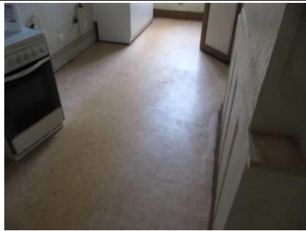
Photo n° A003 Localisation : RDC - Cuisine Ouvrage : Planchers Partie d'ouvrage : Dalles de sol Description : Dalles de sol Localisation sur croquis : A3
