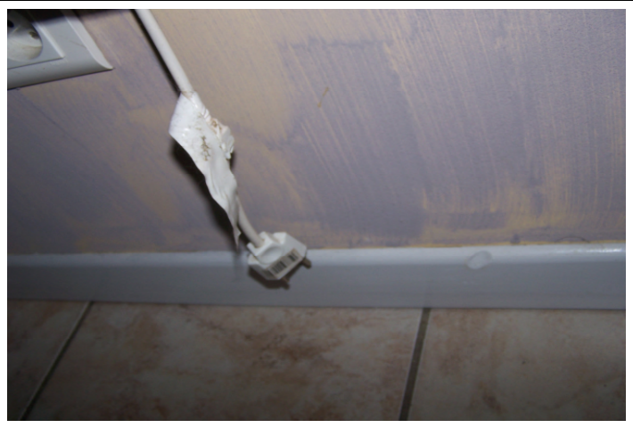
Conducteurs avec connexion mal isolé (convecteur couloir)
