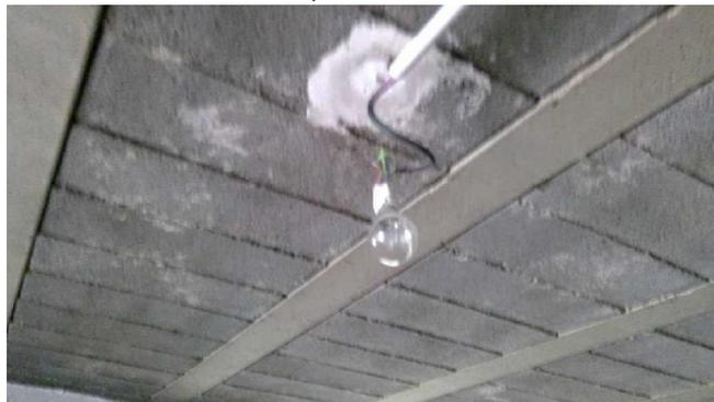
**B.8.3 e)** : Au moins un conducteur isolé n'est pas placé sur toute sa longueur dans un conduit, une goulotte, une plinthe ou une huisserie, en matière isolante ou métallique, jusqu'à sa pénétration dans le matériel électrique qu'il alimente.
