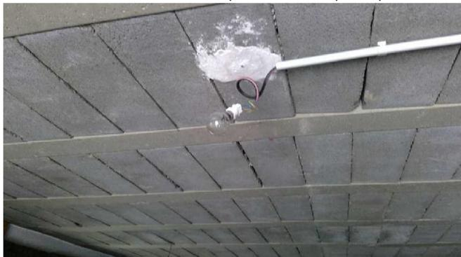
**B.8.3 e)** : Au moins un conducteur isolé n'est pas placé sur toute sa longueur dans un conduit, une goulotte, une plinthe ou une huisserie, en matière isolante ou métallique, jusqu'à sa pénétration dans le matériel électrique qu'il alimente.
