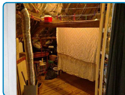
Maison principale 1er étage Grenier
