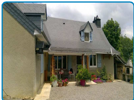
Maison principale Rez de chaussée Extérieur
