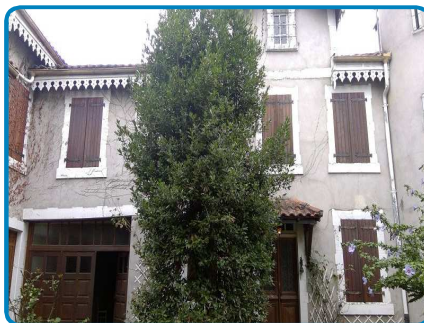
Maison principale Rez de chaussée Extérieur
