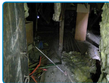
Maison principale 2ème étage Combles
