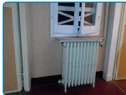
Maison principale 1er étage Dégagement
