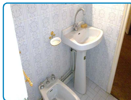
Maison principale 1er étage Salle d'eau 2
