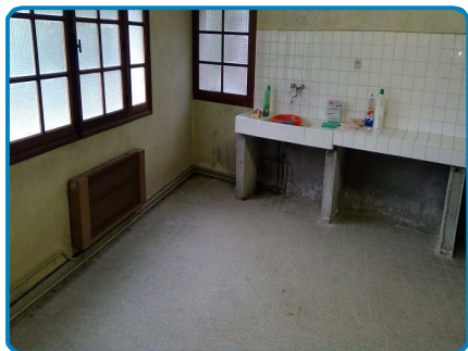
Maison principale Rez de chaussée Pièce 3
