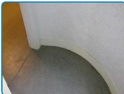
Maison principale 1er étage Dégagement 2
