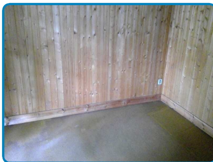
Maison principale 1er étage Pièce 3
