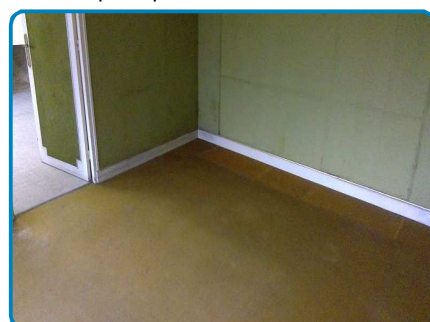
Maison principale Rez de chaussée Pièce 2
