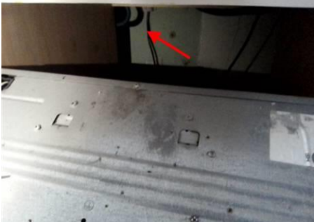
Photo n° PhGaz002 8a2 : au moins un robinet de commande d'appareil n'est pas accessible. (Cuisine) Le robinet de commande n'est pas accessible; Faire déplacer le robinet de commande par un installateur gaz qualifié afin de le rendre accessible
