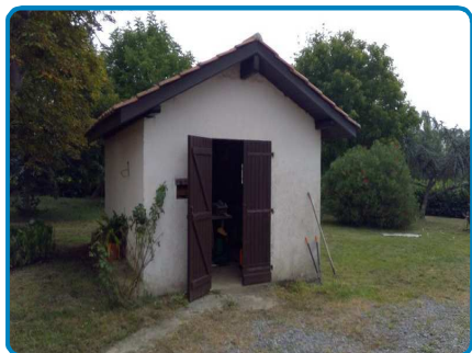
Dépendance Rez de chaussée Garage
