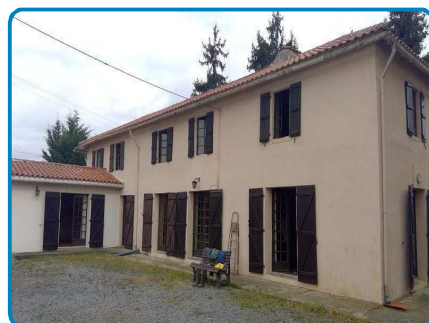
Maison principale Rez de chaussée Extérieur
