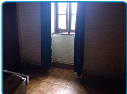
Maison principale 1er étage Dégagement
