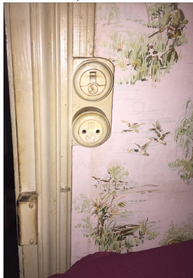
B.3.3.6 a1) : Au moins un socle de prise de courant ne comporte pas de broche de terre.
