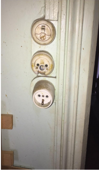
B.3.3.6 a1) : Au moins un socle de prise de courant ne comporte pas de broche de terre.
