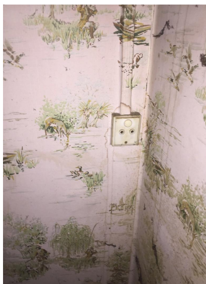
B.3.3.6 a1) : Au moins un socle de prise de courant ne comporte pas de broche de terre.
