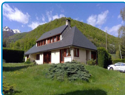
Maison principale Rez de chaussée Extérieur
