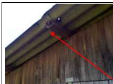
Photo n° PhA001 Localisation : Grange 1 Ouvrage : Toitures Partie d'ouvrage : Plaques (fibres-ciment) Description : Plaques (fibres-ciment) Localisation sur croquis : 001
