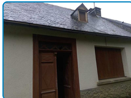
Maison principale Rez de chaussée Extérieur
