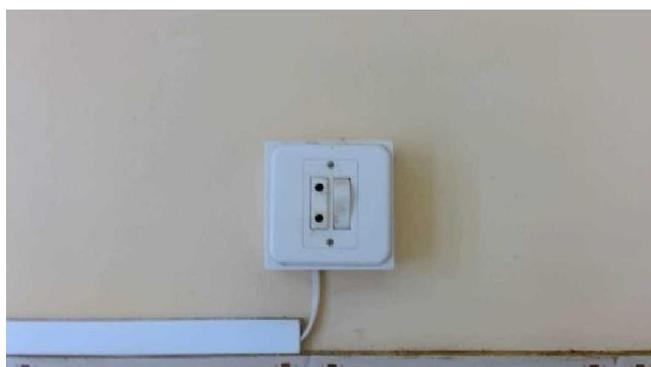
**B.11 b2)** : Au moins un socle de prise de courant n'est pas de type à obturateur.
