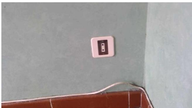
B.11 c2) : Au moins un socle de prise de courant ne possède pas un puits de 15 mm.
