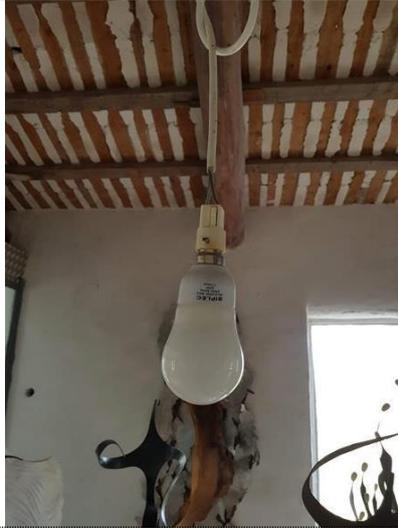
**Description :** Des CONDUCTEURS ou des APPAREILLAGES présentent des traces d'échauffement.
