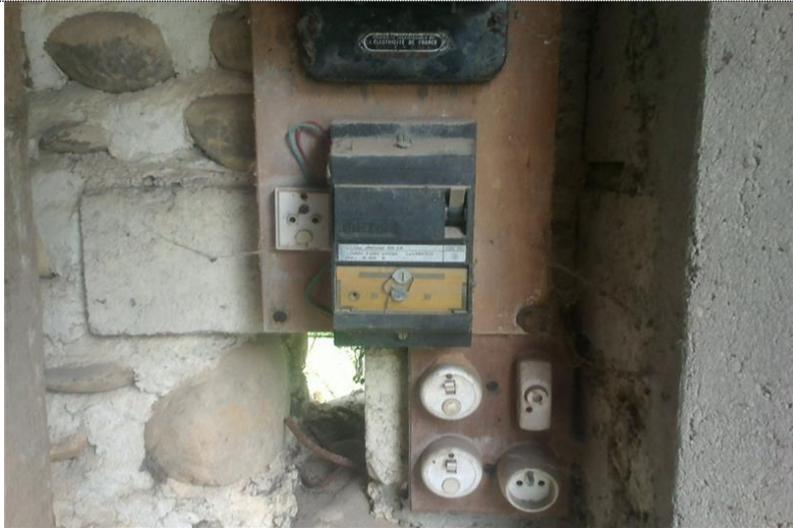
Description : Le dispositif assurant la COUPURE D'URGENCE n'est pas situé à l'intérieur du logement ou dans un emplacement accessible directement depuis le logement.
