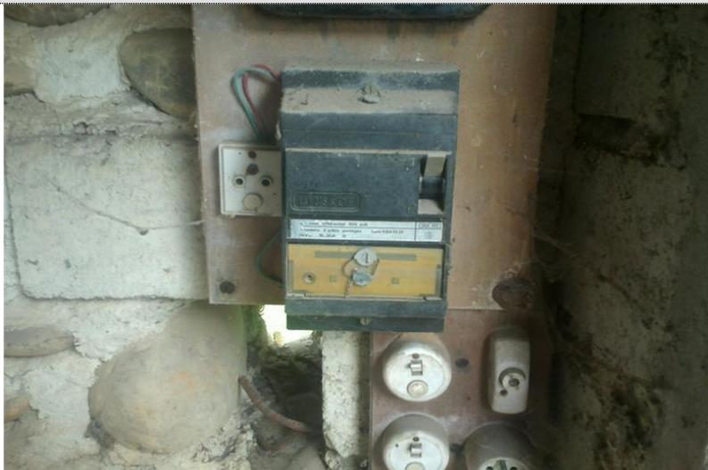
Description : Au moins un dispositif de protection différentielle ne fonctionne pas pour son seuil de déclenchement.
