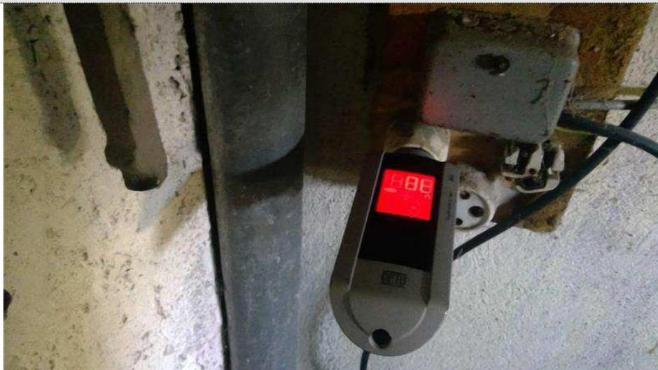
**Description :** La valeur de la résistance de la PRISE DE TERRE n'est pas adaptée au courant différentiel résiduel (sensibilité) du ou des dispositifs différentiels protégeant l'ensemble de l'installation électrique.
