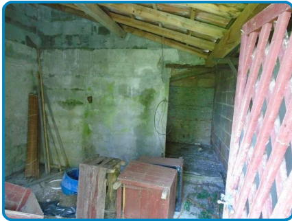
Dépendance Rez de chaussée Remise
