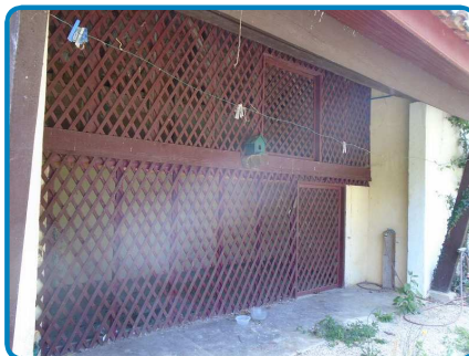
Dépendance Rez de chaussée Auvent
