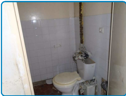
Dépendance Rez de chaussée WC
