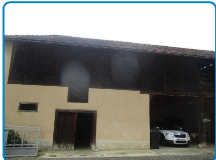
Dépendance 1 Rez de chaussée Extérieur
