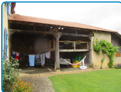
Dépendance 2 Rez de chaussée Extérieur
