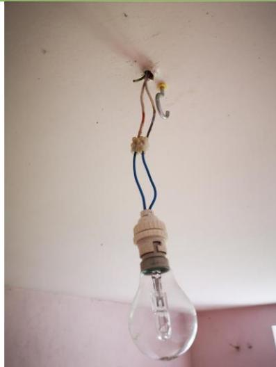
Description : L'installation électrique comporte au moins une CONNEXION avec une partie active nue sous tension accessible.
