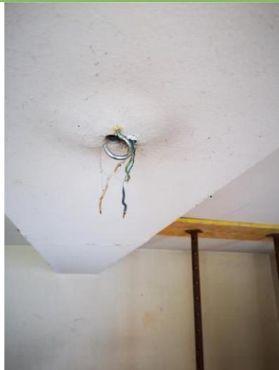
Description : Au moins un CONDUCTEUR nu et/ou au moins une partie accessible est alimenté sous une tension > 25 V a.c. ou > 60 V d.c. ou est alimenté par une source autre que TBTS.
