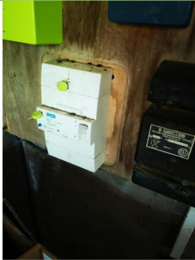
Description : Le dispositif assurant la COUPURE D'URGENCE n'est pas situé à l'intérieur du logement ou dans un emplacement accessible directement depuis le logement.
