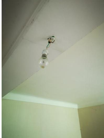
Description : Au moins un CONDUCTEUR isolé n'est pas placé sur toute sa longueur dans un conduit, une goulotte, une plinthe ou une huisserie, en matière isolante ou métallique, jusqu'à sa pénétration dans le MATERIEL ELECTRIQUE qu'il alimente.
