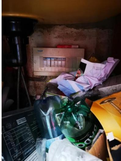
Description : Le (les) tableau(x) de répartition et/ou le DISJONCTEUR de branchement sont placés dans un endroit non admis (sous un point d'eau ou au-dessus de feux ou plaques de cuisson).
