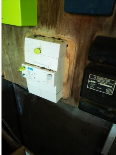
Description : La manoeuvre du bouton test du (des) dispositif(s) de protection différentielle n'entraîne pas (son) leur déclenchement.
