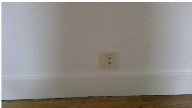
B.3.3.6 a1 ) : Au moins un socle de prise de courant ne comporte pas de broche de terre.
