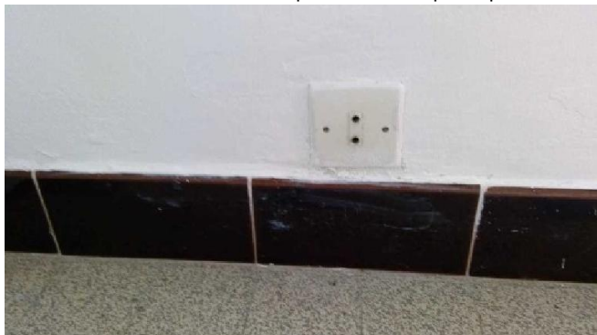
B.3.3.6 a1 ) : Au moins un socle de prise de courant ne comporte pas de broche de terre.
