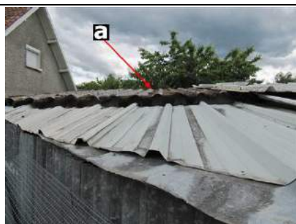
Photo n° A001 Localisation : Parties extérieures Ouvrage : Plaques ondulées Partie d'ouvrage : Plaques en fibres-ciment Description : Plaques en fibres-ciment Localisation sur croquis : 001
