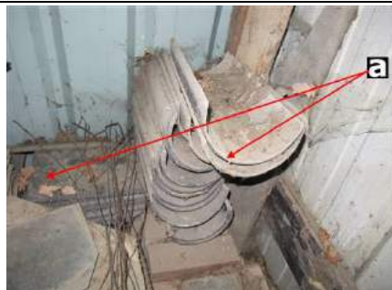
Photo n° A003 Localisation : Parties extérieures Ouvrage : Ardoises Partie d'ouvrage : Ardoises fibres-ciment Description : Ardoises fibres-ciment Localisation sur croquis : 003
