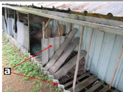
Photo n° A002 Localisation : Parties extérieures Ouvrage : Plaques ondulées Partie d'ouvrage : Plaques en fibres-ciment Description : Plaques en fibres-ciment Localisation sur croquis : 002
