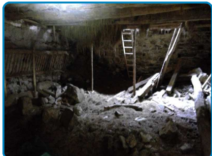
Autre Rez de chaussée Grange
