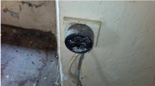
Le type d'au moins un FUSIBLE ou un DISJONCTEUR n'est plus autorisé (fusible à tabatière, à broches rechargeables, COUPE-CIRCUIT A FUSIBLE de type industriel, DISJONCTEUR réglable en courant protégeant des CIRCUITS terminaux).
