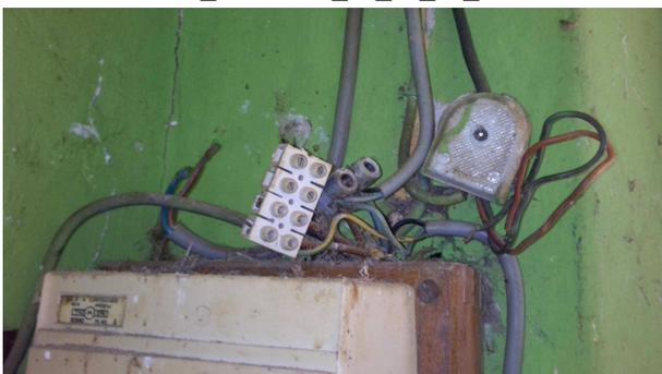
L'installation électrique comporte au moins un dispositif de protection avec une partie active nue sous tension accessible.
