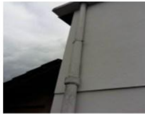
CONDUITS EP FIBRES CIMENT AMIANTES
