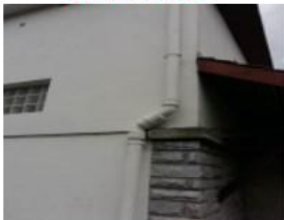
CONDUITS EP FIBRES CIMENT AMIANTES
