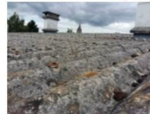
TOITURE FIBRES CIMENT AMIANTES
