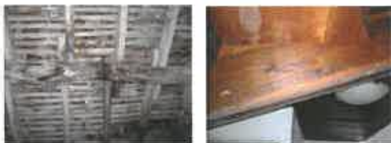
exemples : charpente dépendances, sous-face de l'escalier
