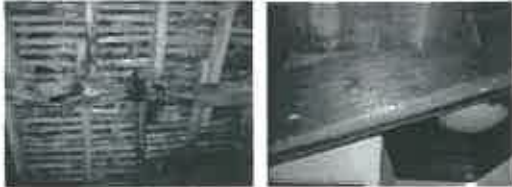
exemples : charpente dépendances, sous-face de l'escalier
