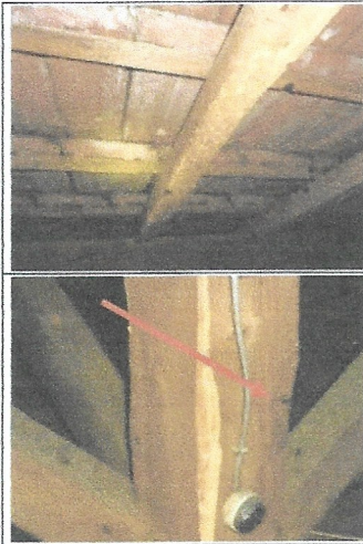
Photo n° Ph001 Localisation : Combles Description : Présence d'injecteurs et bouchage des éléments de charpente
