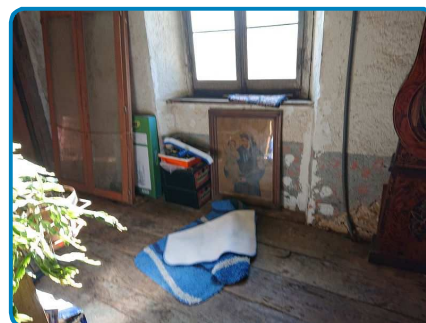
Maison principale 1er étage Palier
