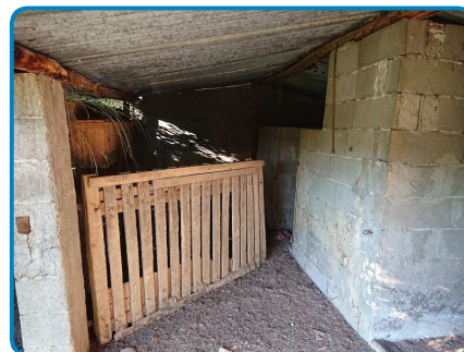
Dépendance Rez de chaussée Abri moutons
