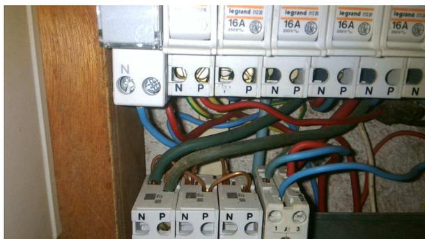
**L'installation électrique comporte au moins une CONNEXION avec une partie active nue sous tension accessible.**
