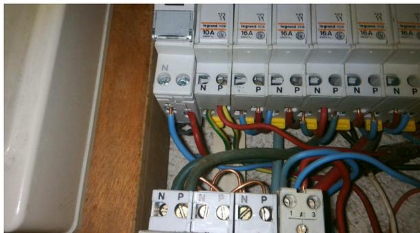
**Au moins un CONDUCTEUR isolé n'est pas placé sur toute sa longueur dans un conduit, une goulotte, une plinthe ou une huisserie, en matière isolante ou métallique, jusqu'à sa pénétration dans le MATERIEL ELECTRIQUE qu'il alimente.**
