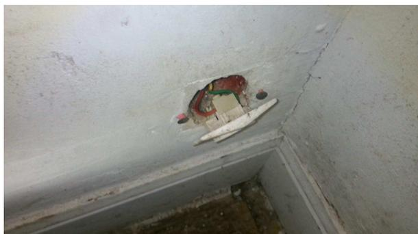
**L'isolant d'au moins un CONDUCTEUR est dégradé.**
