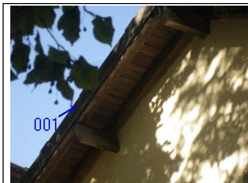
Photo n° 001 Localisation : Extérieur (Toitures habitation et grange) Ouvrage : Toiture, terrasse et étanchéité - Éléments ponctuels Partie d'ouvrage : Élément complémentaire à la toiture Description : Élément complémentaire à la toiture Localisation sur croquis : 001
