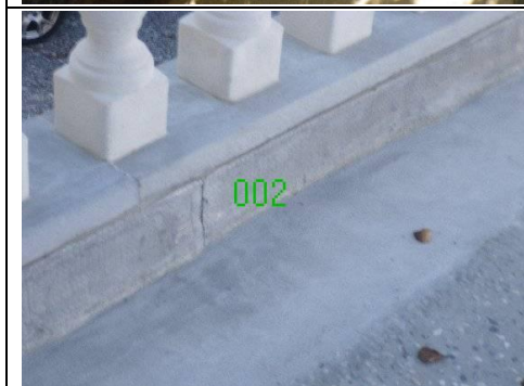
Photo n° 002 Localisation : Extérieur Toiture terrasse Ouvrage : Toiture, terrasse et étanchéité - Complexe d'étanchéité pour toiture Partie d'ouvrage : Bandes bitumineuses Description : Bandes bitumineuses Localisation sur croquis : 002
