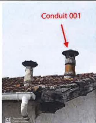
Photo n° PhA001 Localisation : Toiture Ouvrage : Conduits en toiture et façade Partie d'ouvrage : Conduits de fumée en amiante-ciment Description : Conduits de fumée en amiante-ciment Localisation sur croquis : 001
